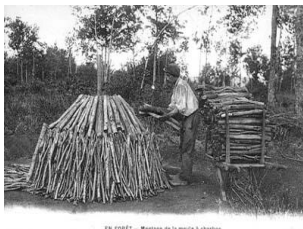
EN FORÊT - Montage de la meule à charbon
