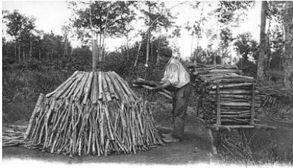
EN FORÊT — Montage de la meule à charbon
