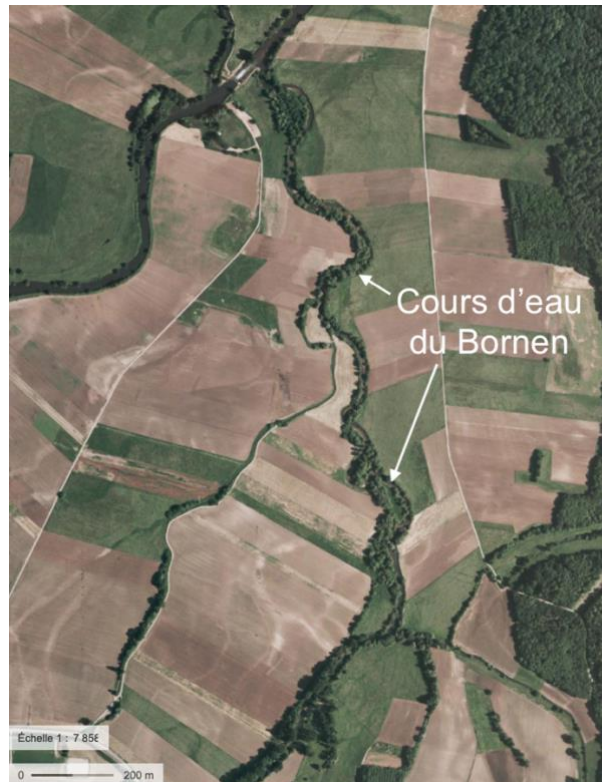
Figure 12 : Portion aval du cours d'eau du Bornen (image Géoportail).
